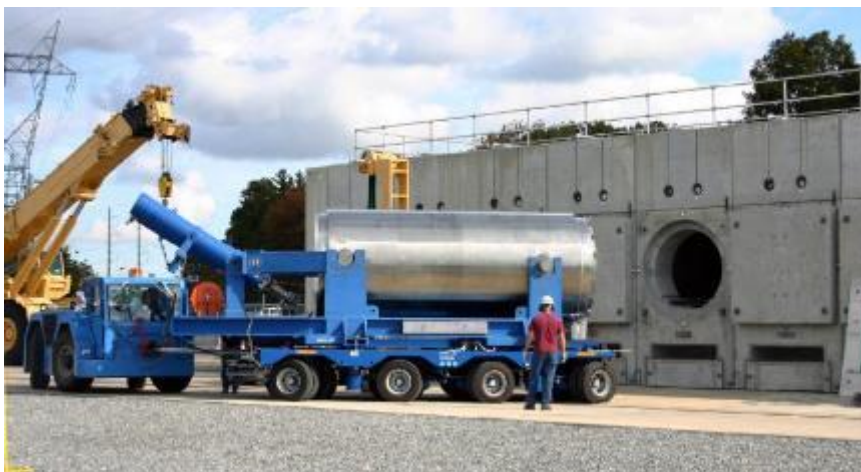
Slika 97: Polnjenje suhega skladišča, horizontalni pogled. [43]
