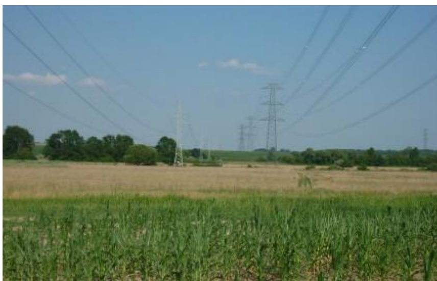
Slika 44: Prenosna linija Pécs-državna meja 400 kV s stebri PINE, linijski koridor
