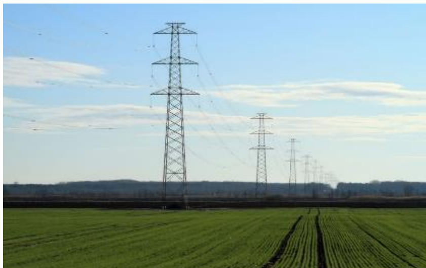
Slika 43: Prenosna linija Martonvásár-Győr 400 kV s stebri PINE
