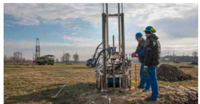
Sekélyfúrási munkák a tervezett telephelyen
