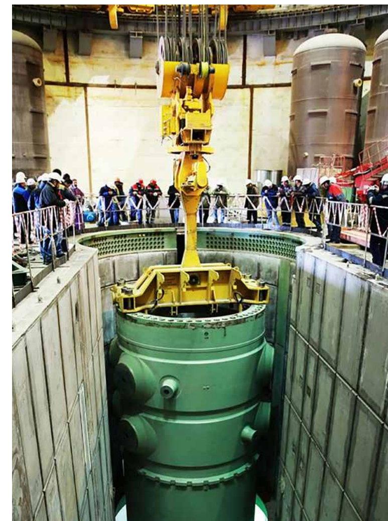
Reaktortartály beemelése (Novovoronyezs) \ forrás: World Nuclear News
