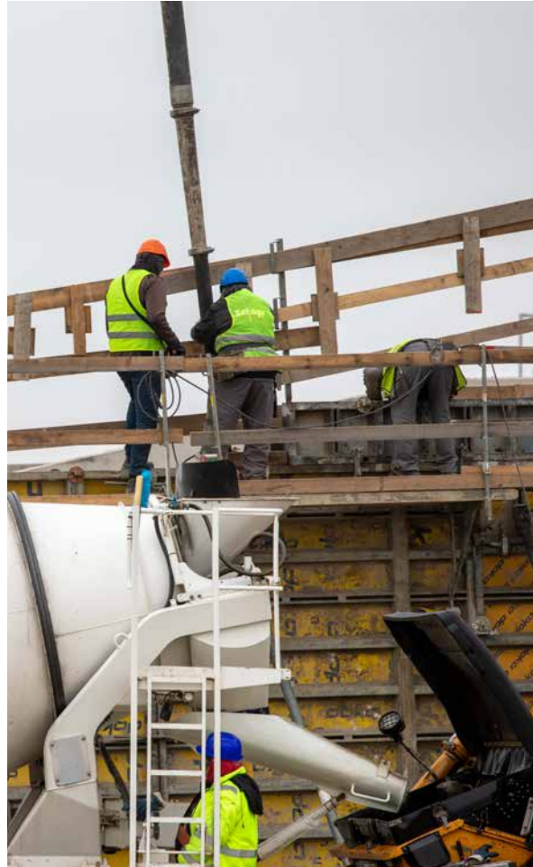
Az atomerőmű megépítéséhez több száz ezer köbméter betont használnak fel. A betonüzem az építési területhez a lehető legközelebb épül fel, hogy ne kelljen a betont nagy távolságból szállítani.
