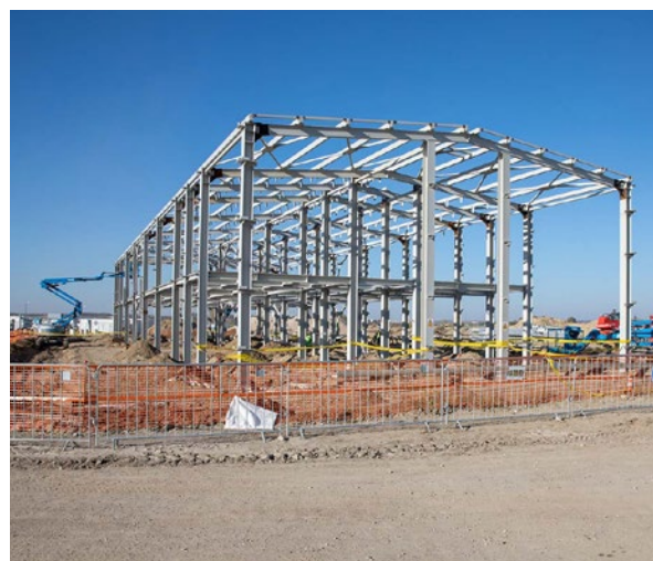
Készül a betonvizsgáló laborépület acélszerkezete a betonkeverő komplexumban.
