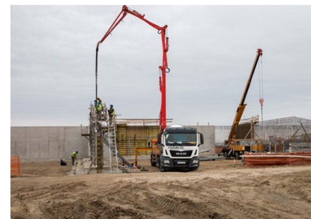
Képünkön a betonkeverő komplexum anyagtároló létesítménye egyik vasbeton falának vasszerelési munkája látható.
