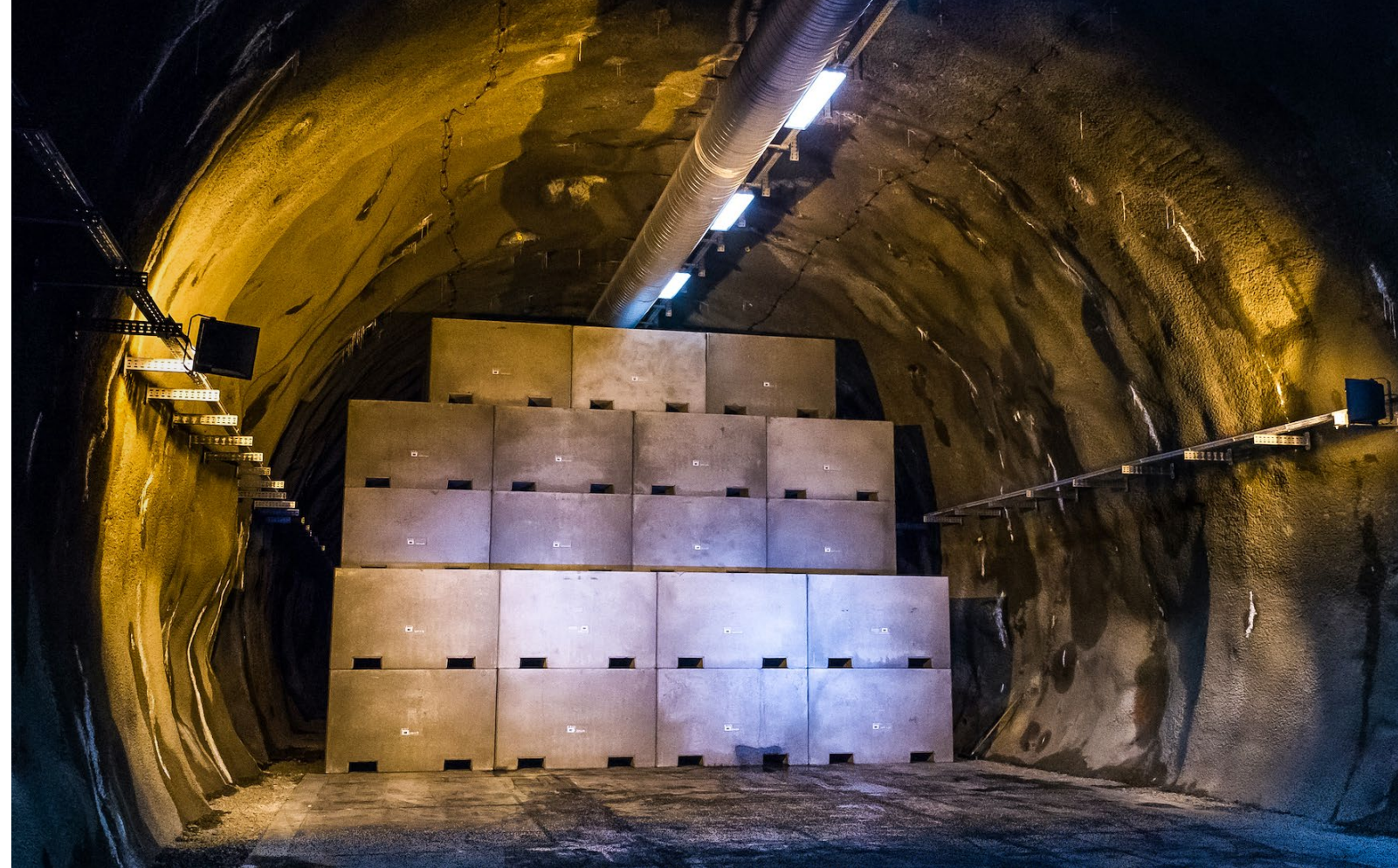
Radioaktív hulladékok az NRHT felszín alatti tárolókamrájában | forrás: rhk.hu
