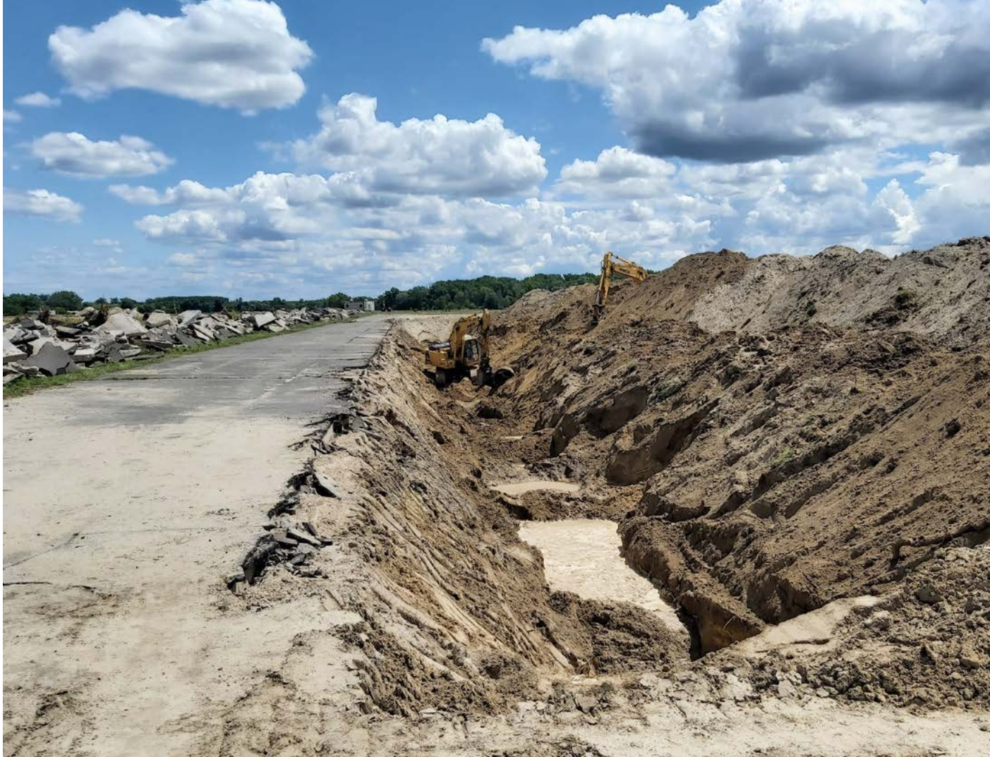
Csapadékvíz- és szennyvízrendszer bontása | Fotó: MVM Paksi Atomerőmű Zrt.
